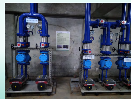
空調設備水泵汰換
