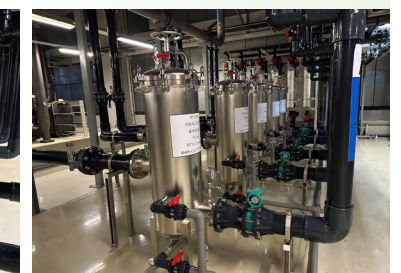
UF 膜改 MF 更換工程 (LCD)
