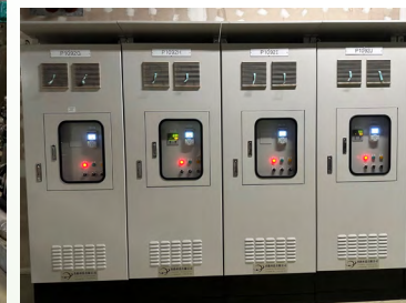
RO 新增 4 套變頻器改善工程
