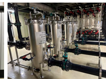
UF 改 MF 更換工程 (TFT)
