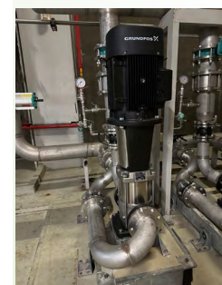
Canned pump 改離心式更換工程
