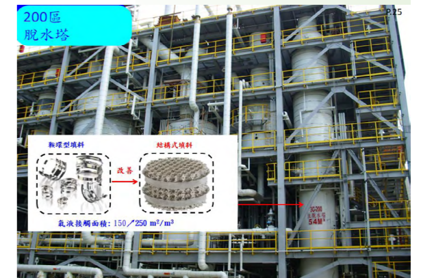
主脫水塔內構件節汽改善
