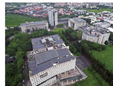
建置屋頂型太陽能發電系統
