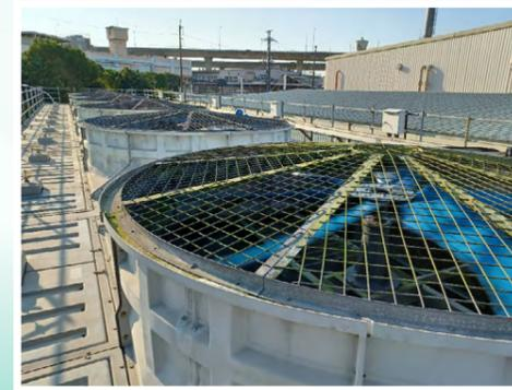
冷卻水塔風扇輕量化
