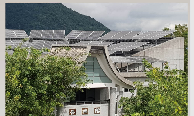
校舍屋頂裝置太陽能板
